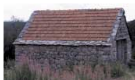
Tuiles mécaniques et lauze
