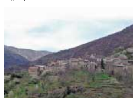
Sablières, vue lointaine
