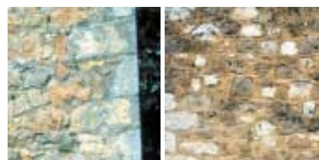
Chaîne taillée et remplissage Joints "beurrés"
