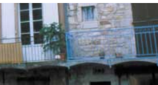
Balcon sur voutains
