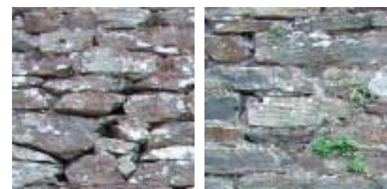
Pierre non jointée Pierre jointée à la chaux
