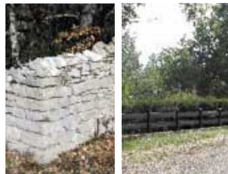
muret de pierres sèches
