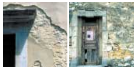
Restes d'enduit Joints "beurrés"
