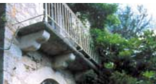
Balcon sur corbeaux en pierre
