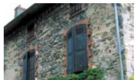
Maison rustique, joints couvrants ou enduit de jointoiment
