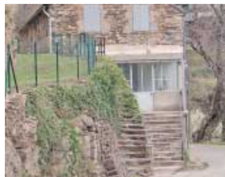
Véranda béton et métal
