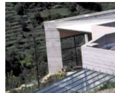
Maison en béton brut
