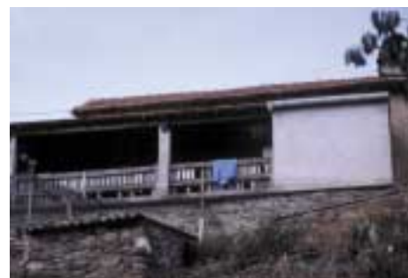
Balustrade en béton
