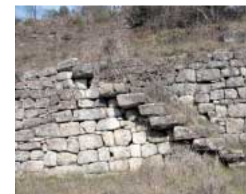
Escalier en grès
