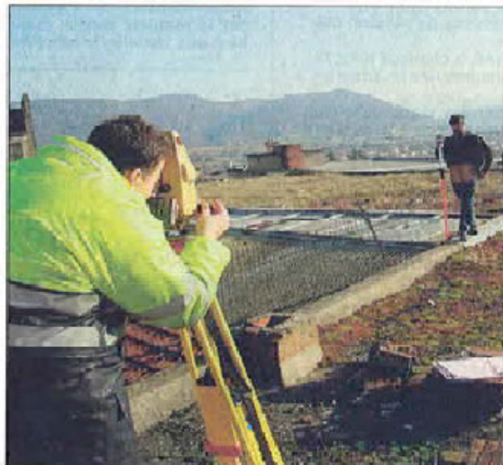
Avec déjà les premiers repérages, le chantier doit démarrer en juin pour une durée estimée à 7-8 mois. Le CAUE pourrait être ainsi dans ses locaux d'ici la fin de l'année ou début 2008. (Photo V.R. / L'In) (1)
