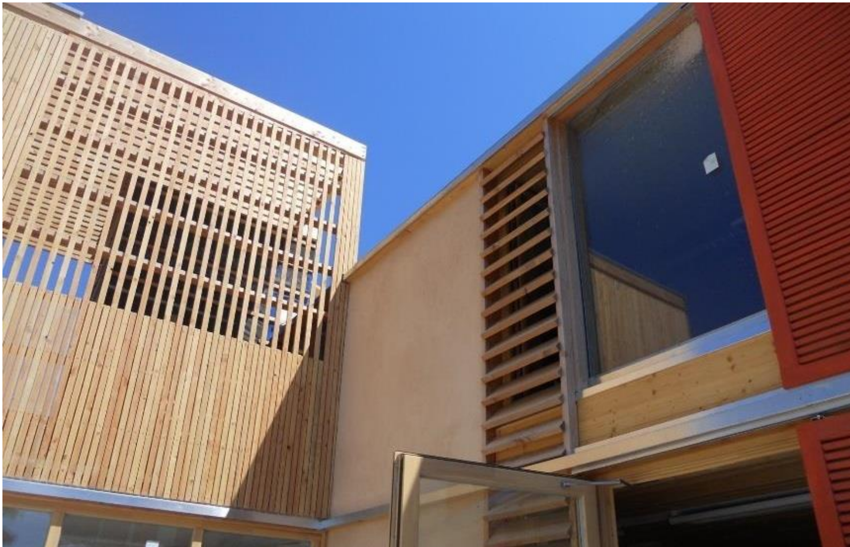
Nouvelle Ecole Montessori d'Avignon (84) – 2012 – BEPAS – Finitions extérieures : enduit terre et bardage bois Maître d'ouvrage : La Maison des Enfants – Architecte : Daniel FANZUTTI
