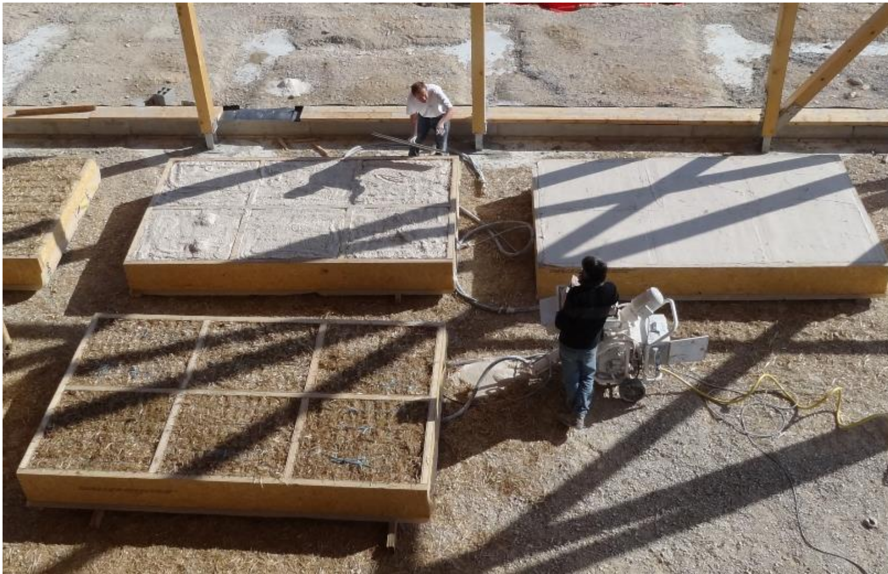
Salle de spectacle à Mazan (Vaucluse) – 2012 – Mise en œuvre de la première couche de plâtre : le « renformis » Maître d'ouvrage : Commune de Mazan – Architectes : François DEFRAIN – Olivier SOUQUET
