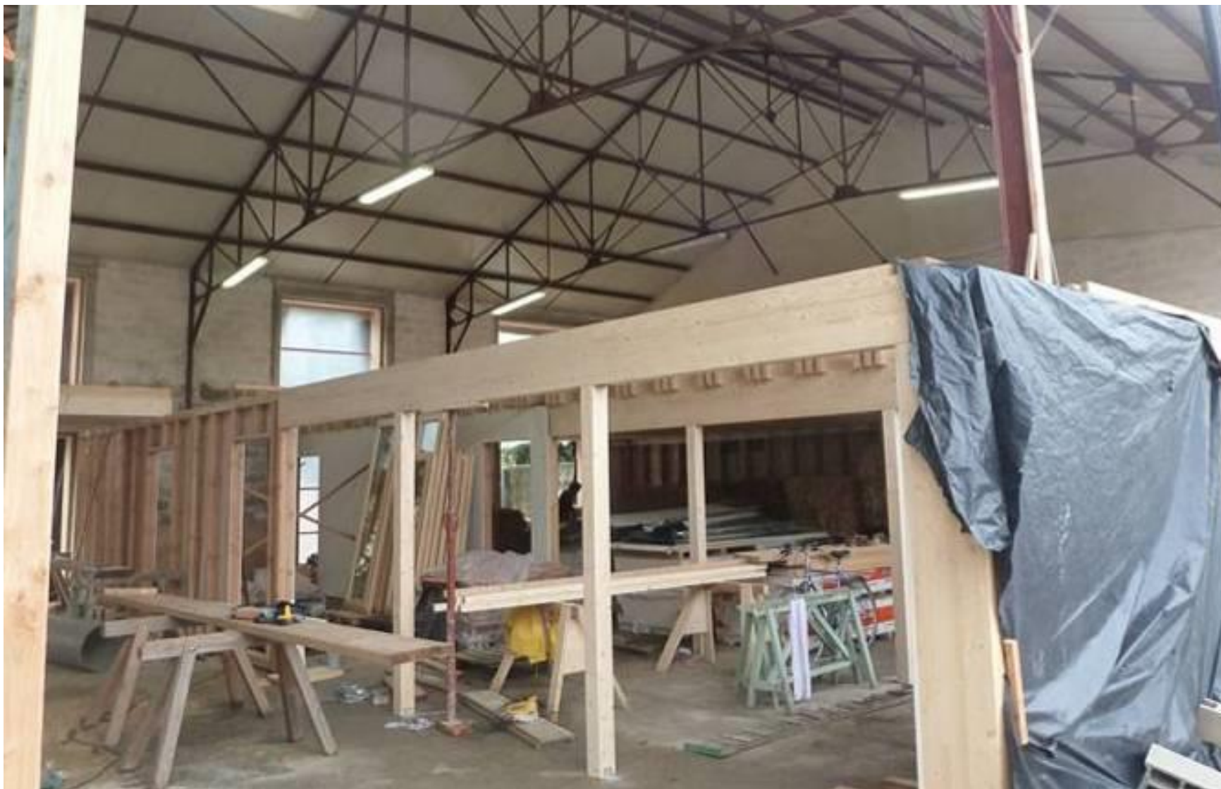
Nouvelle Ecole Montessori d'Avignon (84) – 2012 – BEPAS – Création d'un plancher intermédiaire Maître d'ouvrage : La Maison des Enfants – Architecte : Daniel FANZUTTI
