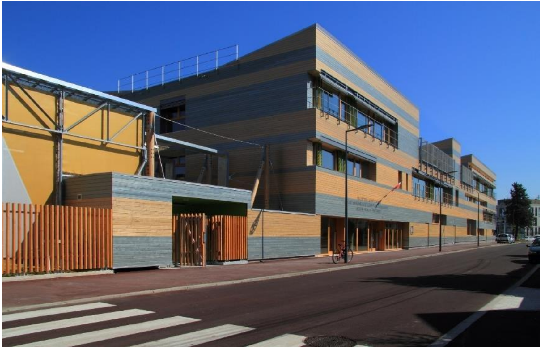
Groupe scolaire Louise Michel à Issy-les-Moulineaux (92) – 2013 – BEPAS – Structure bois et isolation paille Maître d'ouvrage : Ville d' Issy-les-Moulineaux – Architectes : Sonia CORTESSE – Bernard DUFOURNET
