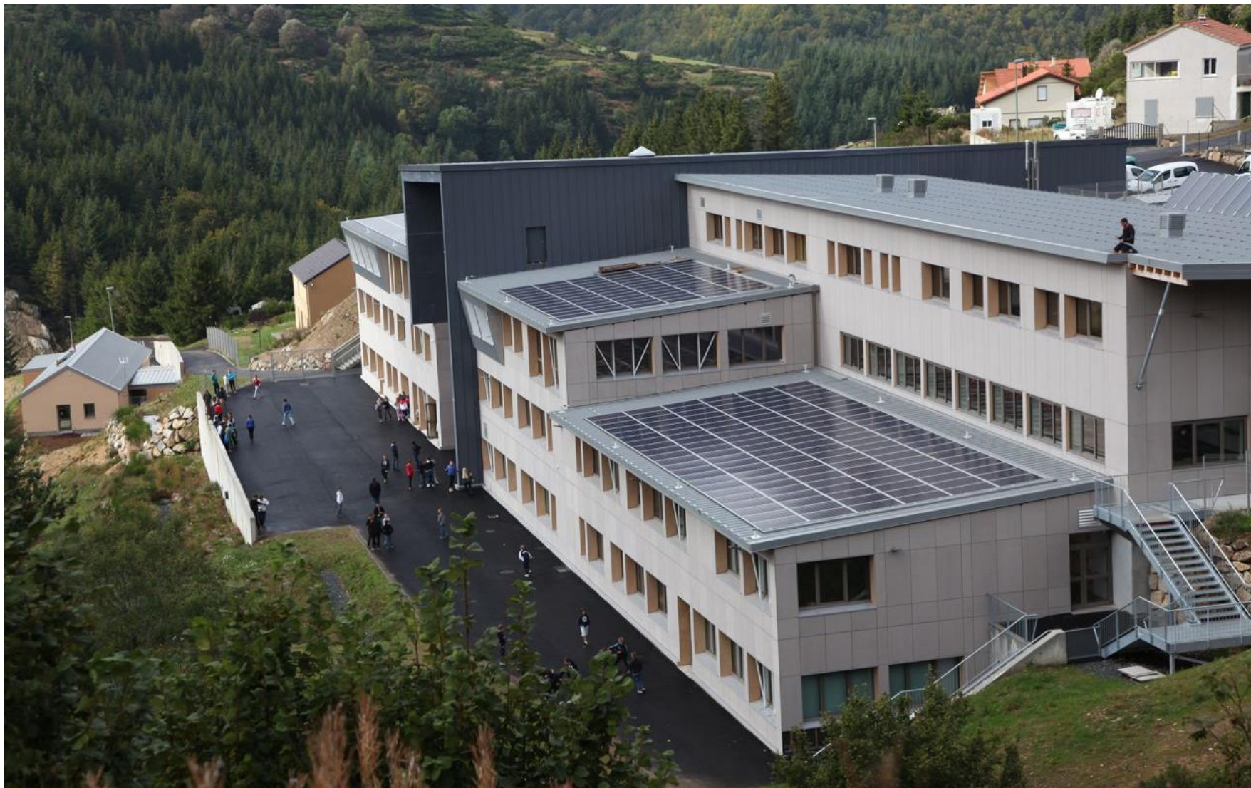
CITE SCOLAIRE DE SAINT-CIRGUES-EN-MONTAGNE – 2014 – Bâtiment bois – paille à énergie positive Maître d'ouvrage : Département de l'Ardèche - Architectes : Agence Charnay + Fabre & Doinel Associés – Entreprise : Moulin Charpente
