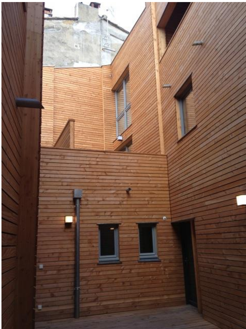
Réhabilitation d'un immeuble médiéval à Avignon (84) – 2011 – BBC – Ossature bois et ouate de cellulose Maître d'ouvrage : SCPI Pierre Investissement – Architectes : Atelier LEFEVRE – B+T Architectes
