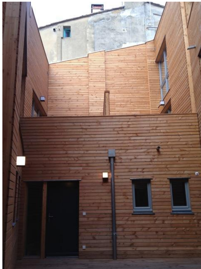
Réhabilitation d'un immeuble médiéval à Avignon (84) – 2011 – BBC – Ossature bois et ouate de cellulose Maître d'ouvrage : SCPI Pierre Investissement – Architectes : Atelier LEFEVRE – B+T Architectes
