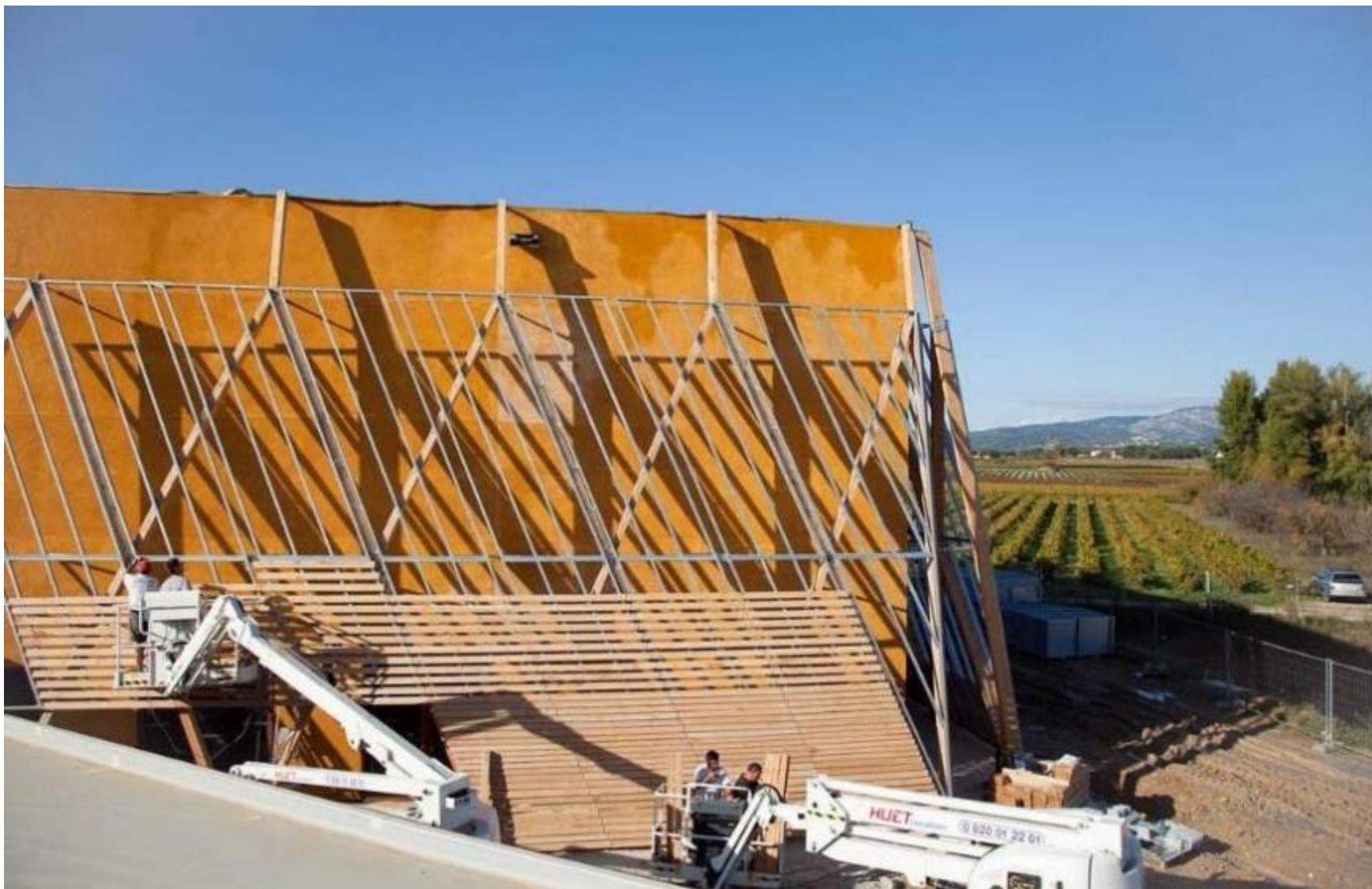
Salle de spectacle à Mazan (Vaucluse) – 2012 – Mise en œuvre du bardage en cèdre Maître d'ouvrage : Commune de Mazan – Architectes : François DEFRAIN – Olivier SOUQUET
