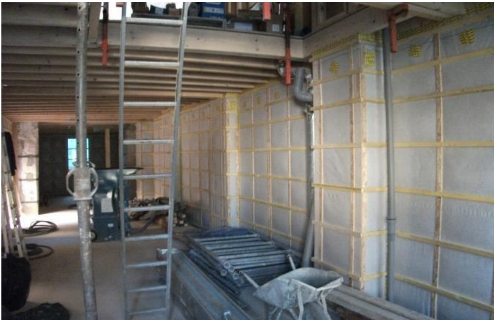
Réhabilitation d'un immeuble médiéval à Avignon (84) – 2011 – BBC – Ossature bois et ouate de cellulose Maître d'ouvrage : SCPI Pierre Investissement – Architectes : Atelier LEFEVRE – B+T Architectes
