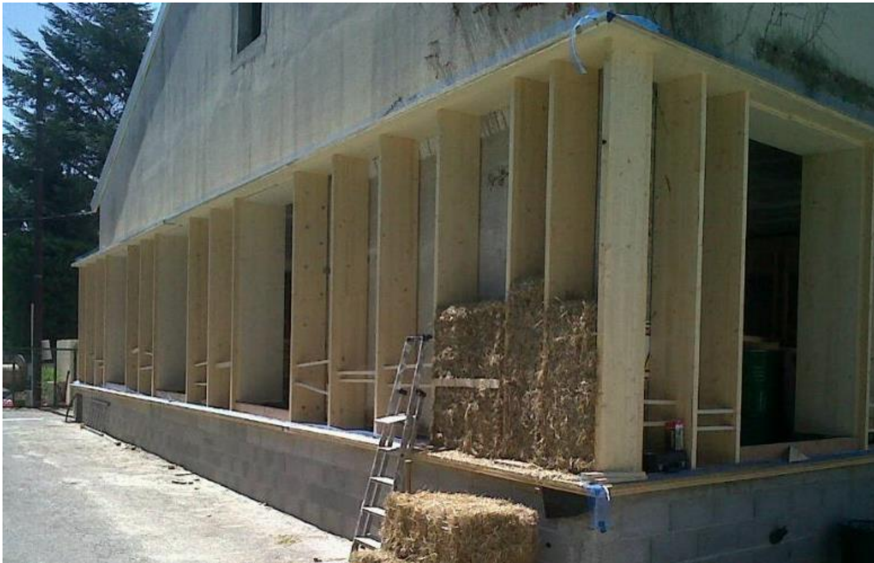
Nouvelle Ecole Montessori d'Avignon (84) – 2012 – BEPAS – Insertion des bottes de paille dans l'ossature bois Maître d'ouvrage : La Maison des Enfants – Architecte : Daniel FANZUTTI
