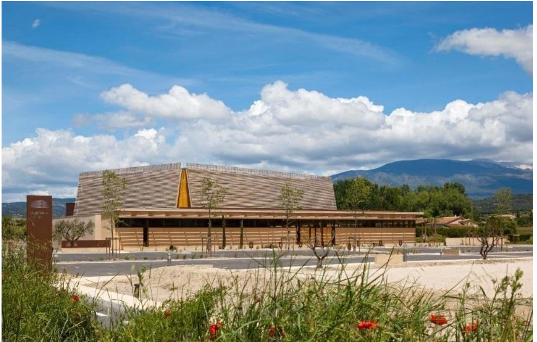
Salle de spectacle à Mazan (Vaucluse) – 2012 – Structure bois local, isolation paille et enduit plâtre Maître d'ouvrage : Commune de Mazan – Architectes : François DEFRAIN – Olivier SOUQUET
