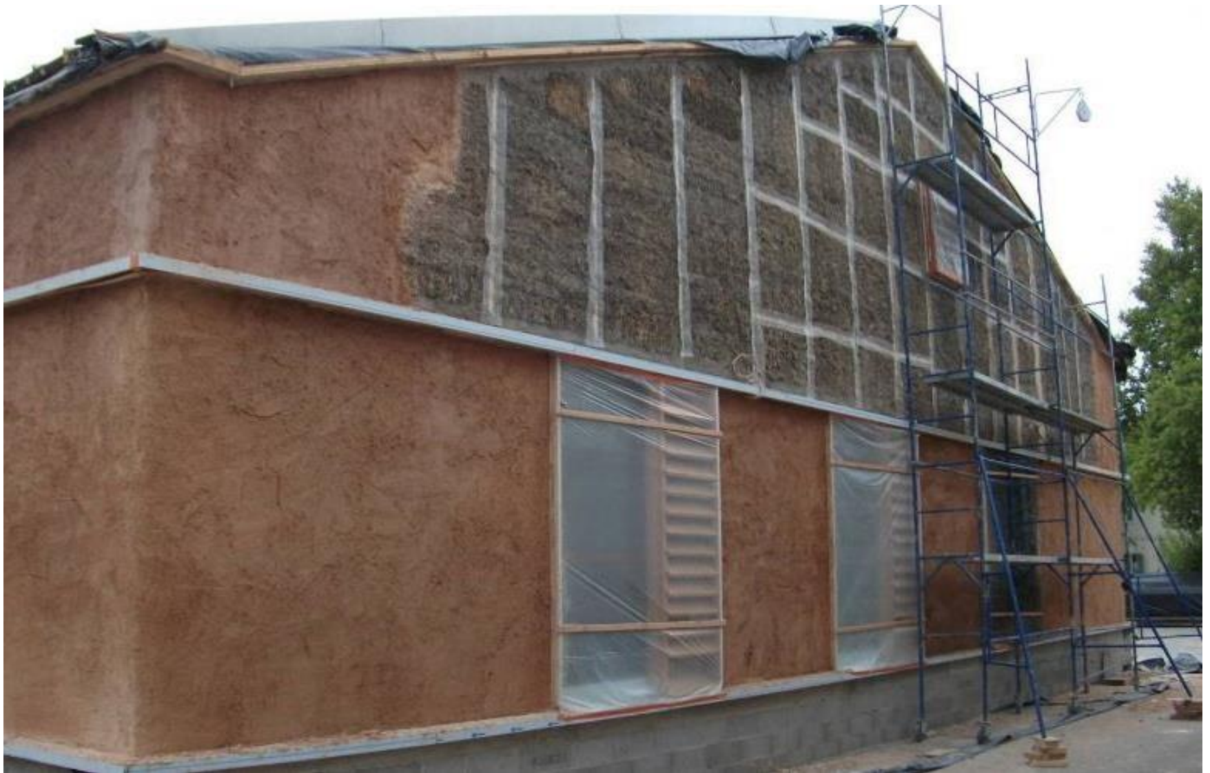
Nouvelle Ecole Montessori d'Avignon (84) – 2012 – BEPAS – Enduits terre : gobets et corps d'enduit Maître d'ouvrage : La Maison des Enfants – Architecte : Daniel FANZUTTI
