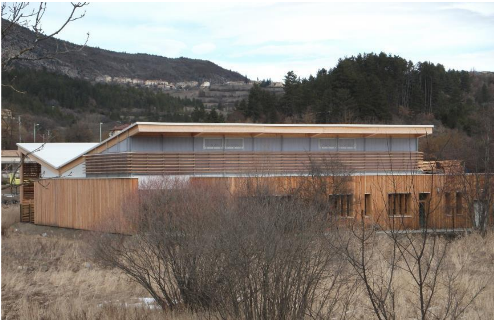
Atelier de l'ONF à BARREME (04) – 2012 – Structure bois et isolation paille – Bois fourni par la Commune Maître d'ouvrage : Commune de Barrême – Architecte : Frédéric NICOLAS
