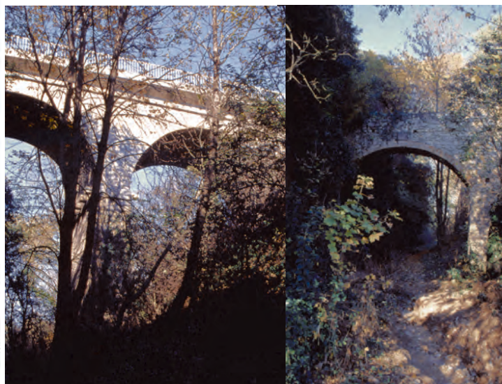
Quartier de Tourne : pont de la RD 358 vers Bidon et aqueduc en ruine
