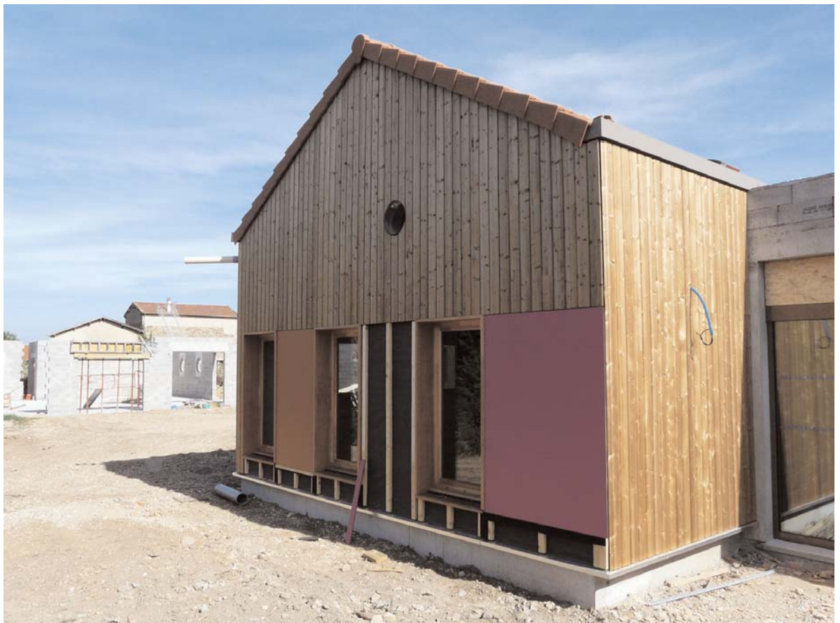
Traitement des façades de la crèche, mai 2009
