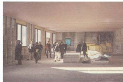
A l'intérieur des bâtiments, le travail est important surtout pour la réalisation de la dalle supérieure qui supportera la nouvelle terrasse.
