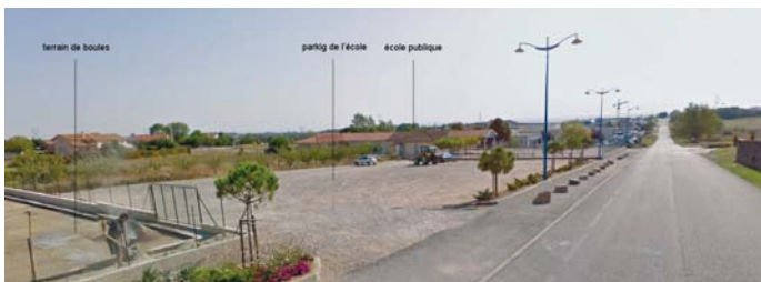
État des lieux du site
