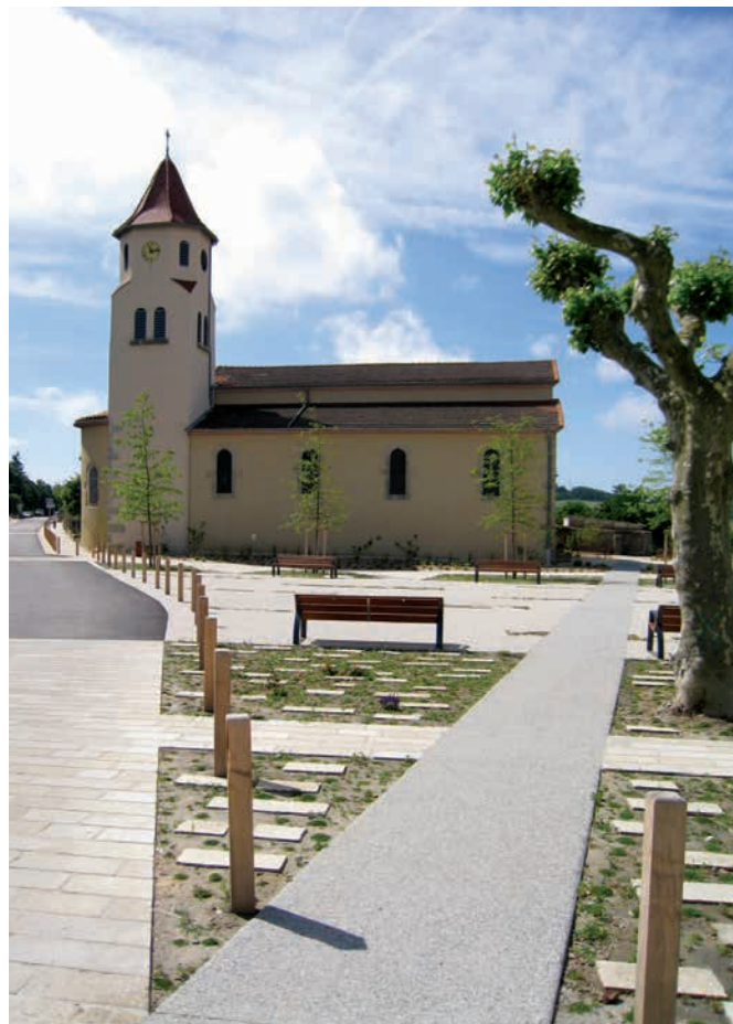
La place après travaux
