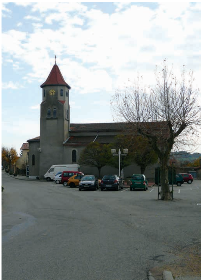
La place avant travaux
