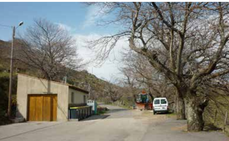
Le bâti des services techniques
