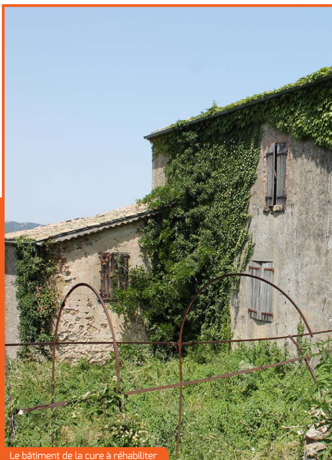
Le bâtiment de la cure à réhabiliter
