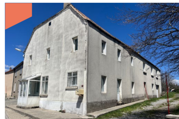
LACHAMP-RAPHAËL REQUALIFICATION D'UN BÂTIMENT VACANT
